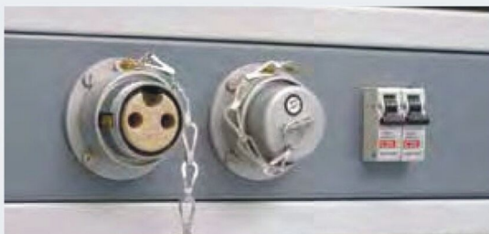
• Metal clad socket
